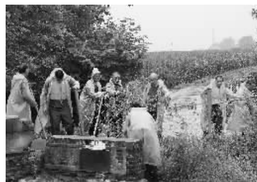
队员们在加固河堤防护网。
