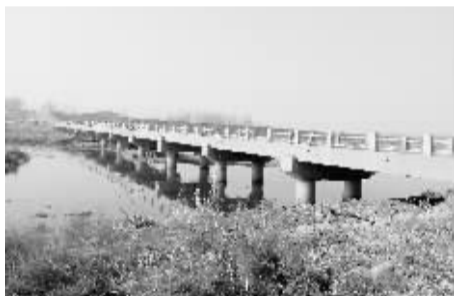
新钢筋混凝土桥
